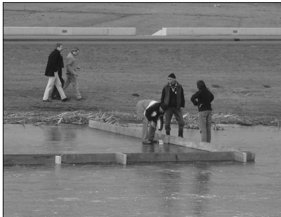
Baan in aanbouw.
