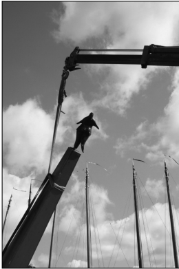
Het beeld in de takels voordat ze op het fundament gezet wordt.
